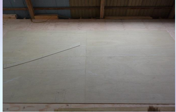
断面図の原寸図をベニヤに描き型取り
