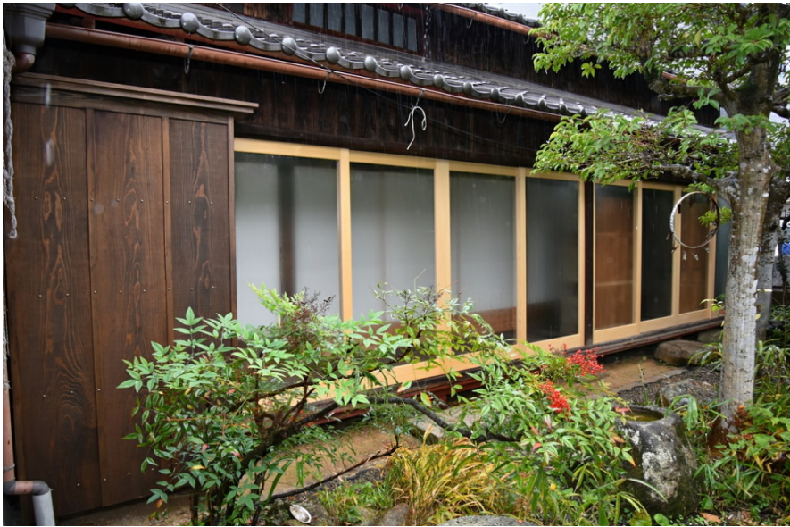
西廊下 ガラス戸 新調 檜材 戸袋 新調 杉材
