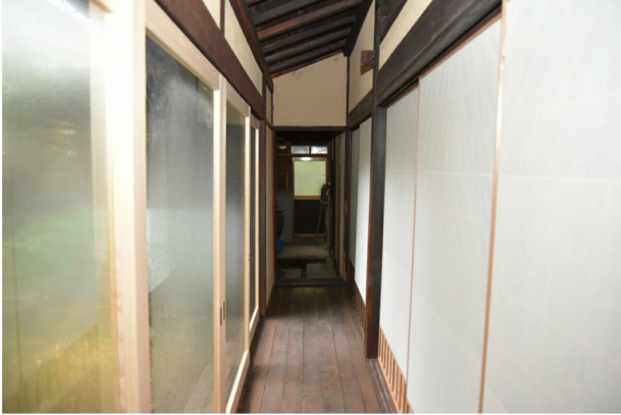
西廊下 ガラス戸新調
